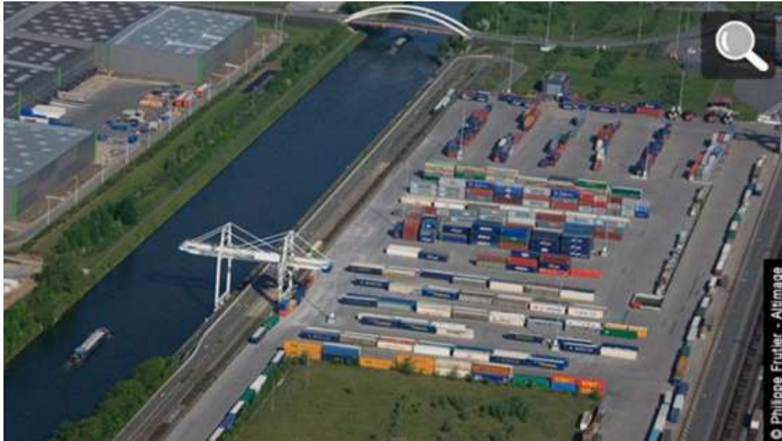
Plateforme multimodale de Douges
